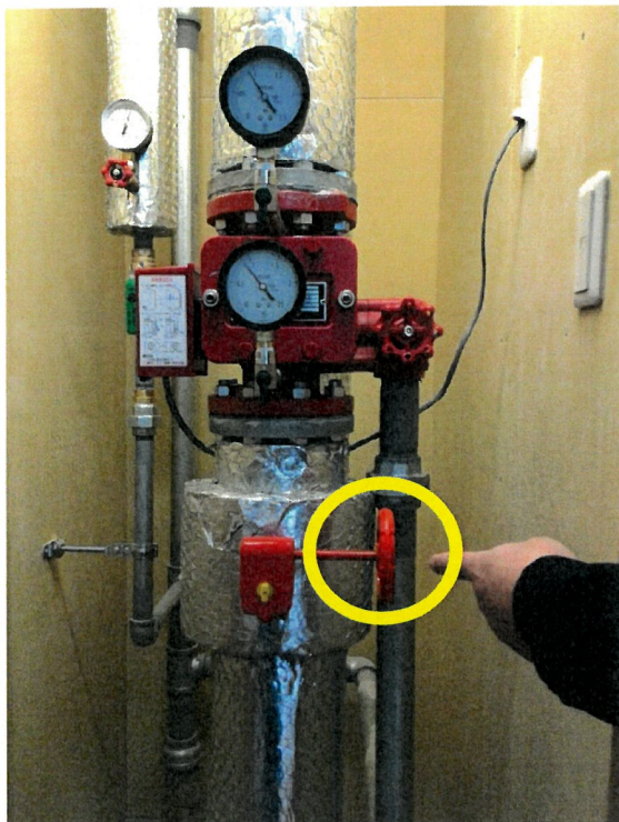
スプリンクラー制御弁
